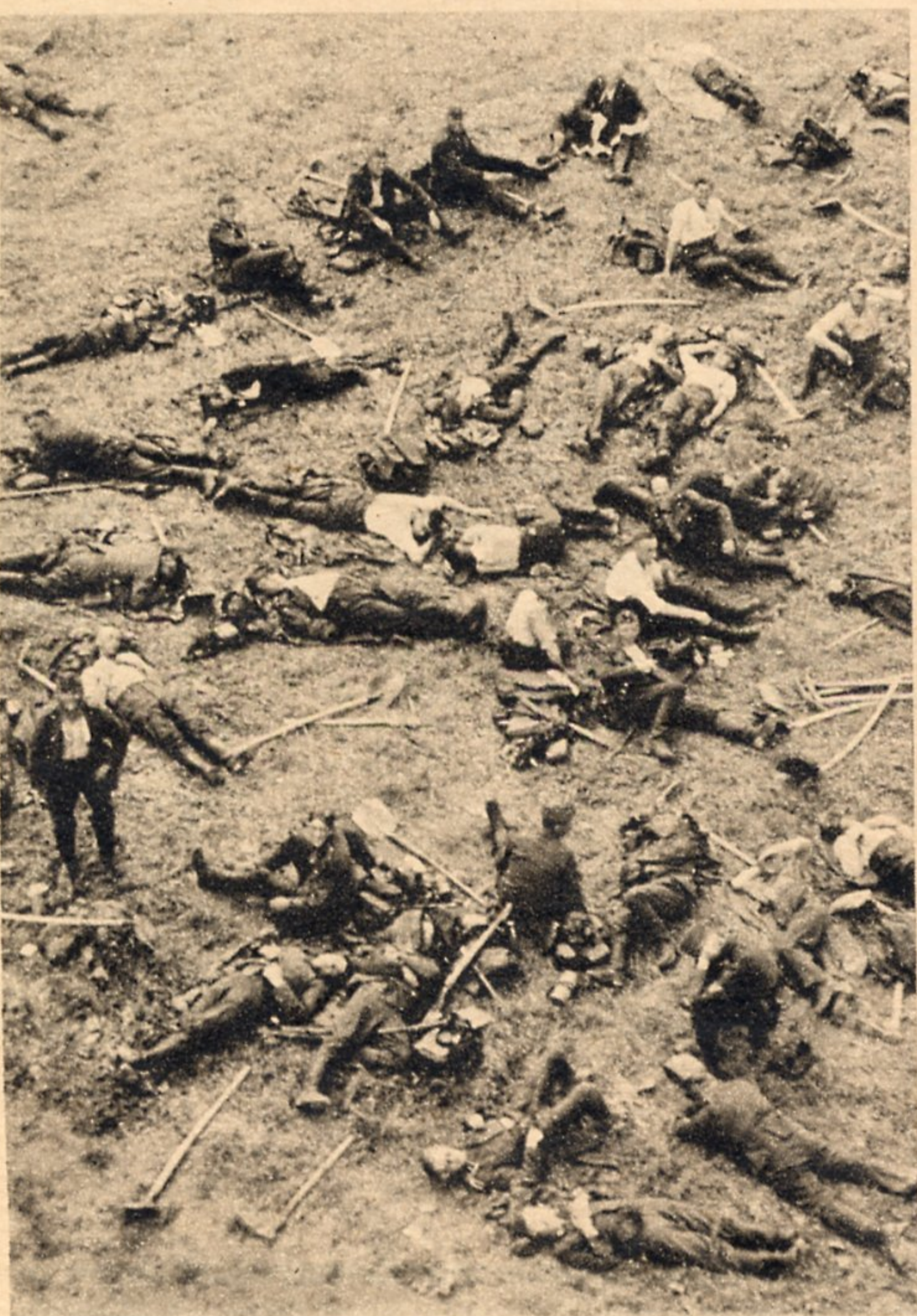
Flugzeugaufnahme einer Luftwaffen-Baukompanie, die mit Arbeiten auf einem Feldflughafen beschäftigt ist und hier ihre Mittagsruhe hält
